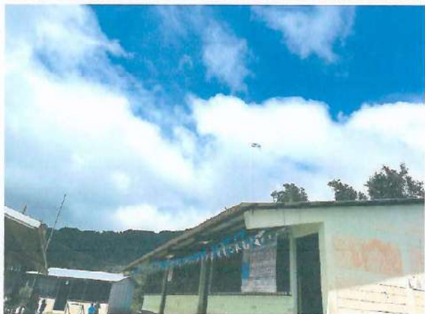
Foto 1: Mejoramiento de techo tipo pórtico
